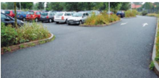
Enrobé poreux sur structure réservoir
