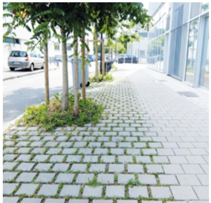
Exemple de **pavés à joints engazonnés** - Nantes
