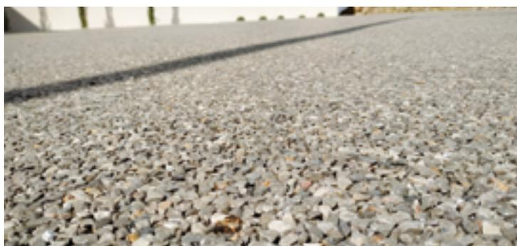
Exemple de béton de résine drainante (©JDM Expert)
