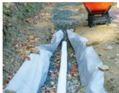
Pose d'un drain pour faciliter les écoulements
