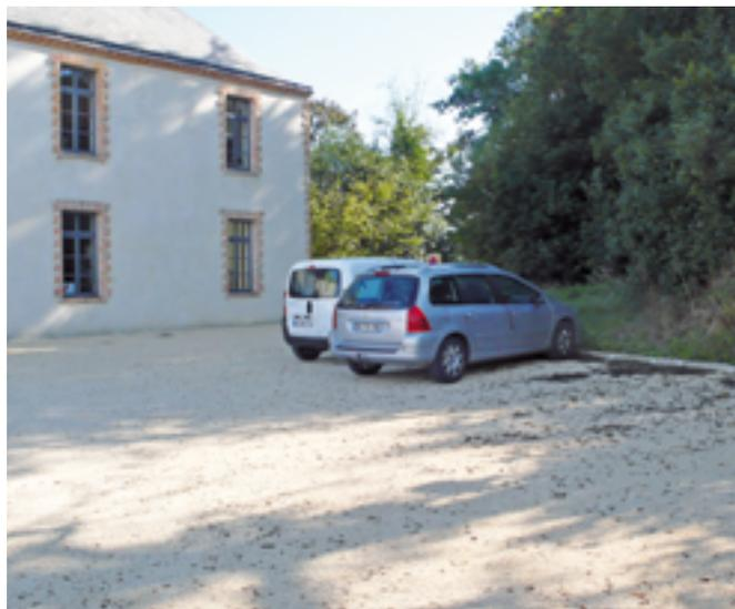
Exemple de parking perméable en graviers
