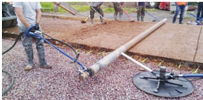
Coulage et réglage à l'aide d'un roller-striker
