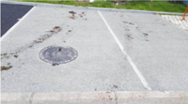
Exemple de risque de colmatage précoce dû au déplacement de remblais sur un revêtement perméable
