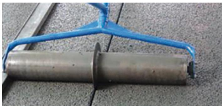
Coulage et réglage à l'aide d'un roller-striker
