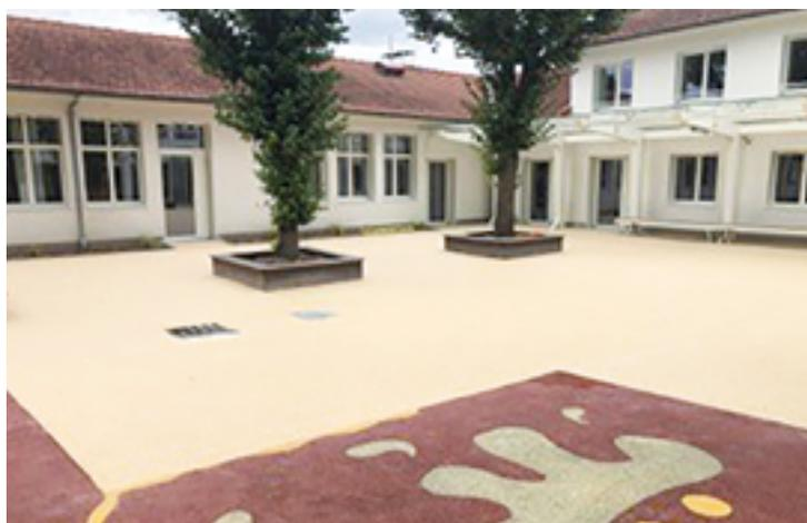
Utilisation d'un béton de résine dans une cours d'école
