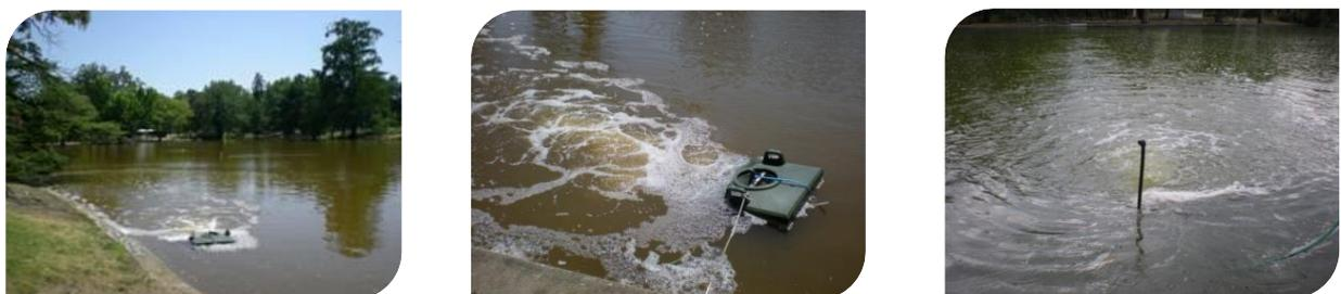
Figure 4. Différentes vues des aérateurs immergés dans le bassin.
