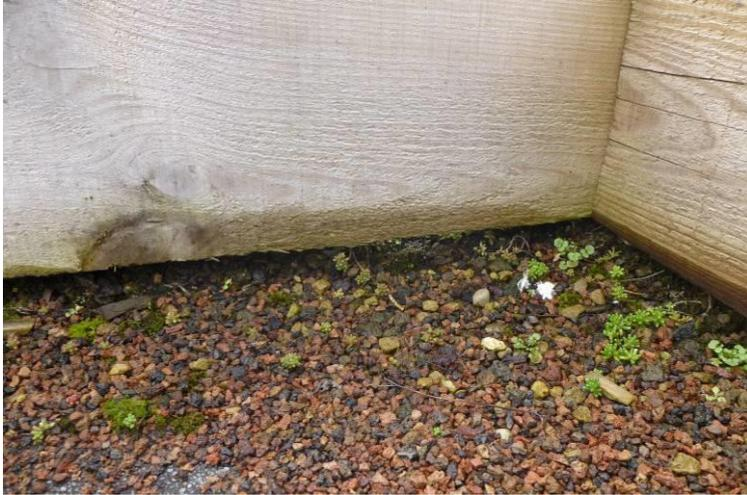
Photo 4 : Surélévation des éléments de séparation assurant la continuité du drainage.
