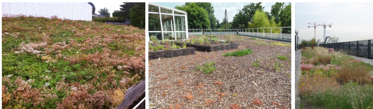
Figure 4 : Trois des toitures de l'observatoire des plantes de toitures (DR)
