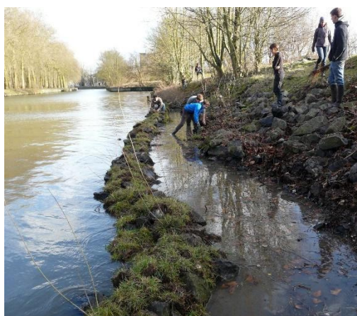
Lille / Renaturation de berge sur la Deûle.
