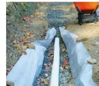
Pose d'un drain pour faciliter les écoulements (source : Ecohabitat.org)
