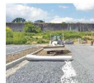
Pose d'une géotextile (© C2D, Esplanade du Champ de Mars - Lille)
