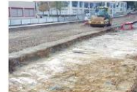
Exemple de terrassement d'une zone accueillant un revêtement perméable (© PNC - Robin Dagot)
