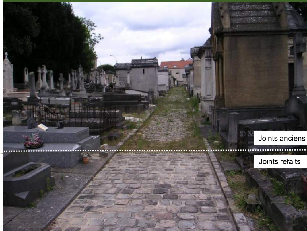
Réfection des joints des pavés à Versailles
