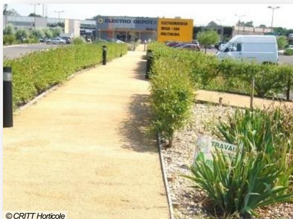
**Illustration 8 – Infiltration sur place.** Cheminement récréatif en graviers résinés infiltrants. Après une première épuration\* par le dispositif, les eaux sont infiltrées puis stockées dans un ouvrage enterré. La végétalisation est réalisée à partir de saules et a été guidée pour servir de garde-corps.
