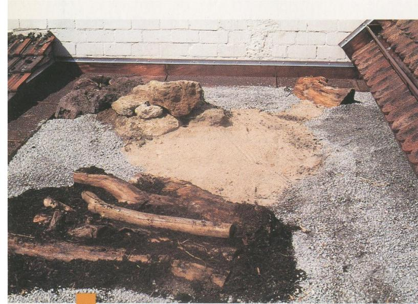
Différentes compositions de substrat et de paillage permettent la réalisation de diverses conditions de sols et de microclimats, même sur de petites surfaces.
